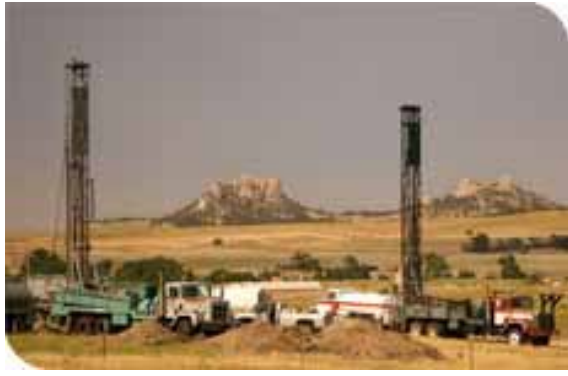
Рис. 152. Щелочное скважинное выщелачивание на урановом руднике, США.
